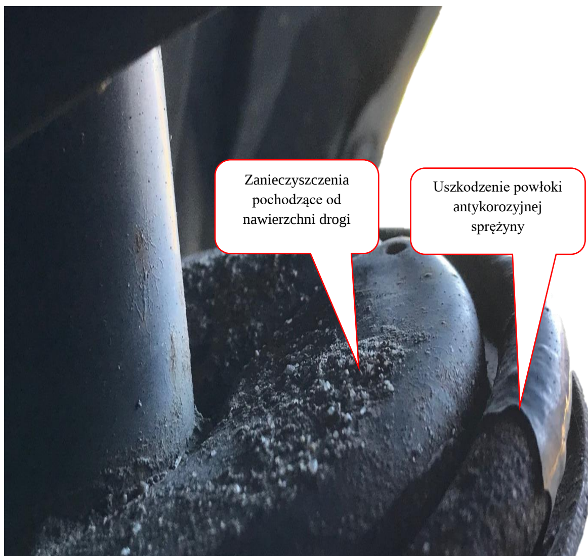
Rysunek 3.4. Przykładowe uszkodzenie powłoki antykorozyjnej sprężyny kolumny McPhersona oraz widoczne zanieczyszczenia.
