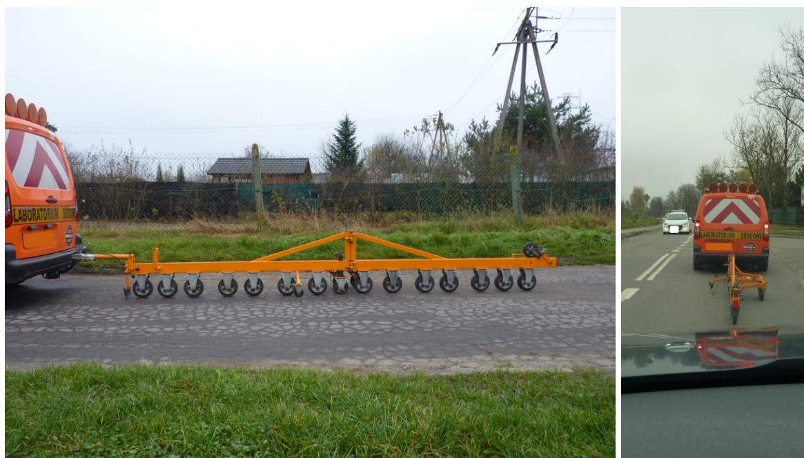
Rysunek 6.4. Pomiar równości nawierzchni wybranego odcinka drogi.
