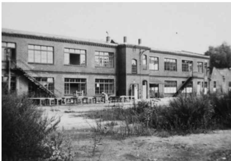
Ilustracja 11. Budynek Bauhausu w Berlinie, zdjęcie nieznanego autora, 1932 Unidentified artist, Bauhaus Building, Berlin-Steglitz, 1932 (Harvard Art Museums)
